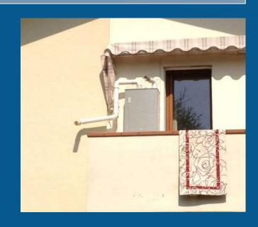
La caldaia a camera aperta può essere ancora installata solo nel caso di edifici plurifamiliari, per sostituire generatori che scaricano in fumi in canne fumarie collettive ramificate.
